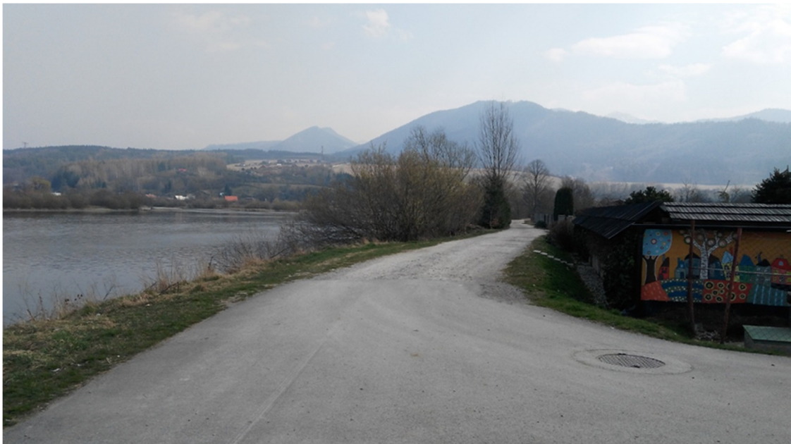
Obrázok 10: Obec Strečno - Časť cyklotrasy - "Cyklotrasa Hrad Budatín - Hrad Strečno, SO C.5 cyklotrasa Strečno - inventarizácia drevín a prieskum biotopov", foto autor, 29.3.2020
